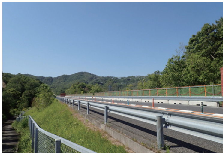
和歌山県 NEXCO西日本 阪和道尻掛橋下部工工事
