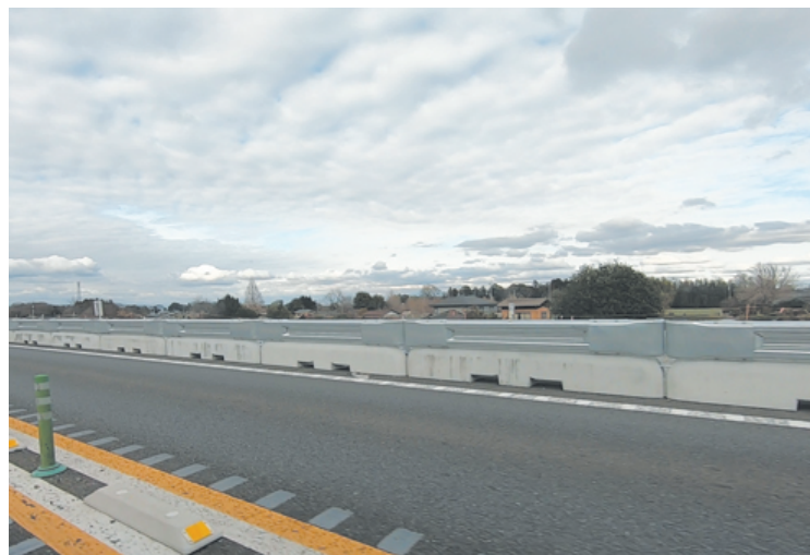
茨城県 NEXCO東日本 首都圏中央連絡自動車道 島名舗装工事
