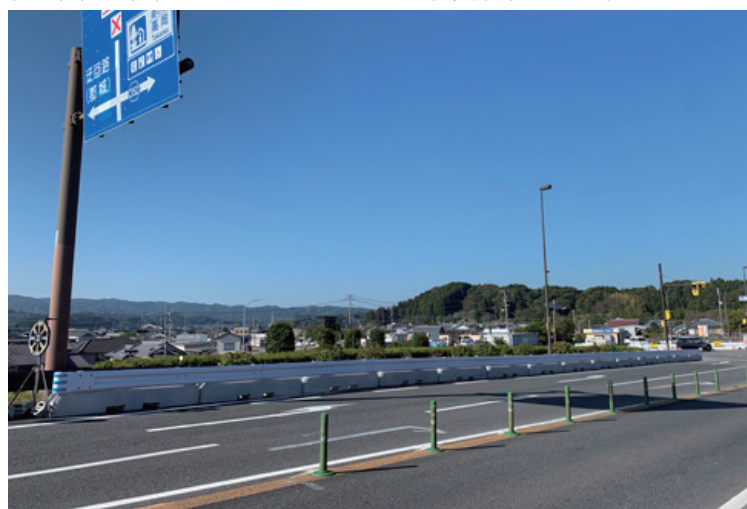
宮崎県 花見地区コンクリート舗装新設外工事
