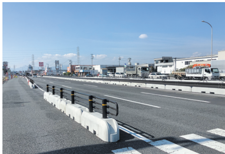
岐阜県 21号岐大BP茜部地区西道路建設工事
