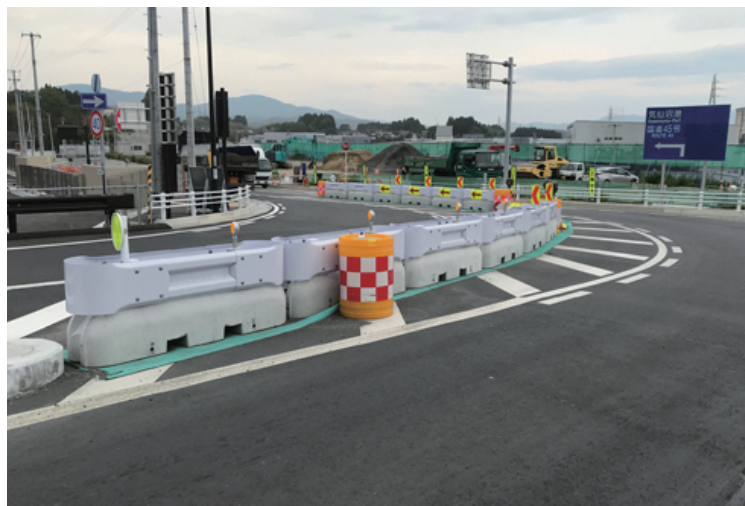
宮城県 松崎北地区舗装工事
