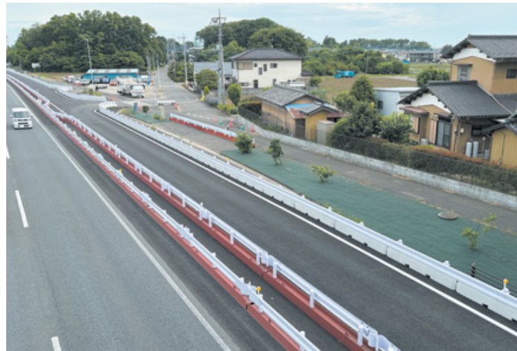
埼玉県 国道17号新大宮上尾道路西新井地区
