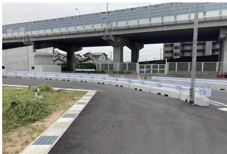
兵庫県 姫路バイパス苦編跨線橋
