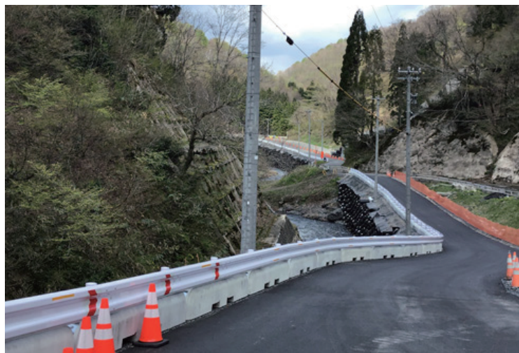
福井県 冠山峠道路田代地区改良工事
