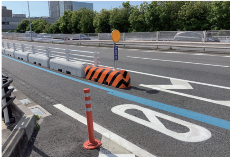
愛知県 名古屋市 市道豆田町線自転車利用環境整備工事 先端工
