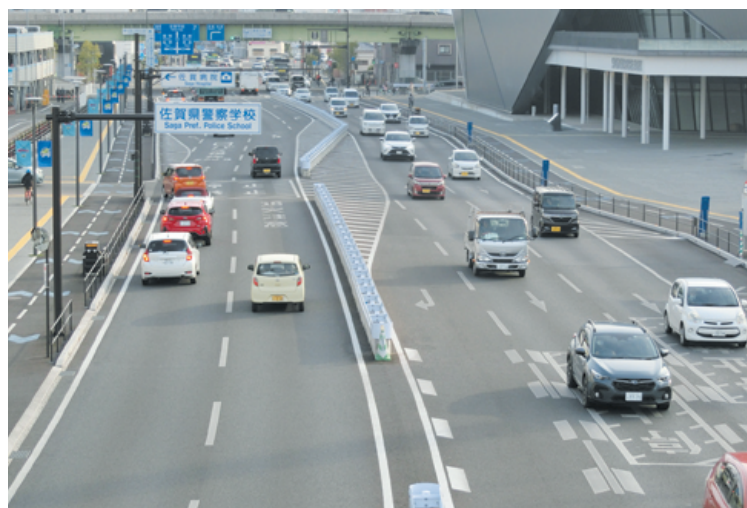
佐賀県 国道263号 道路整備交付金工事
