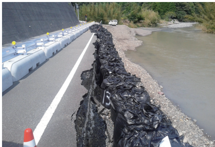
高知県 安芸川災害復旧工事
