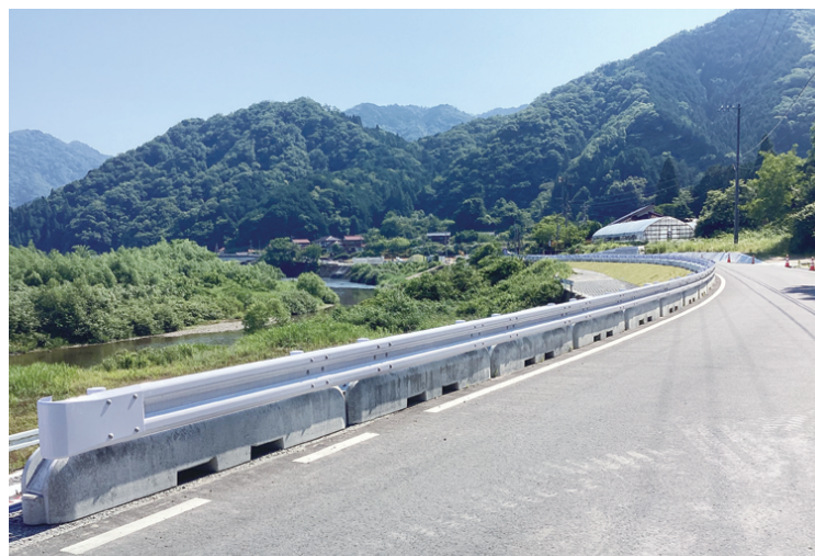
島根県 八戸川県単河川災害関連工事
