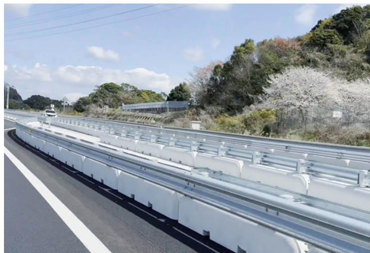
長崎県 NEXCO西日本 佐世保道路白岳舗装工事
