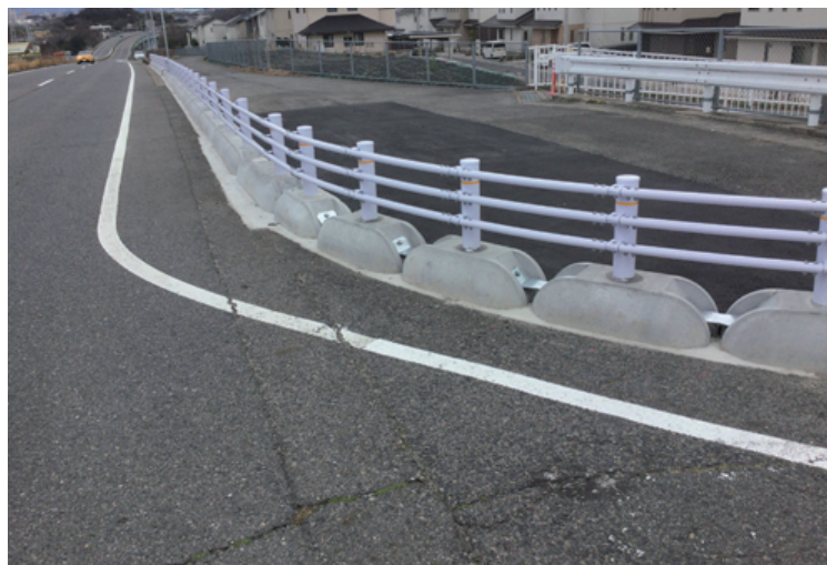
愛知県 名古屋国道事務所管内交通安全対策工事
