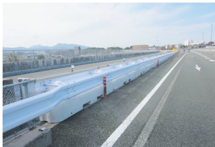
熊本県 熊本3号植木バイパス外道路付属物設置工事
