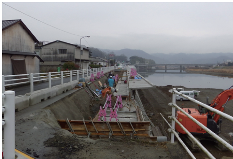
岡山県 国道486号線災害復旧工事 H30西日本豪雨
