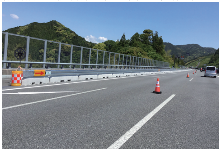
静岡県 NEXCO中日本 新東名高速道路6車線化工事 藤枝岡部～新静岡間
