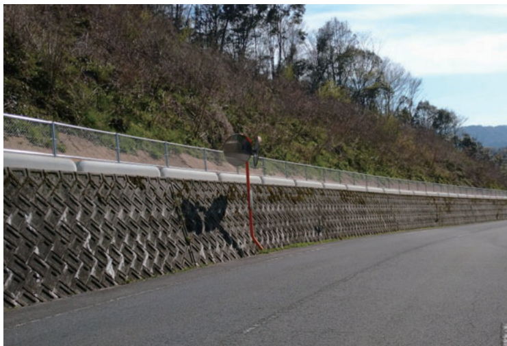
香川県 まんのう町(大規模農道防護柵) フェンス基礎
