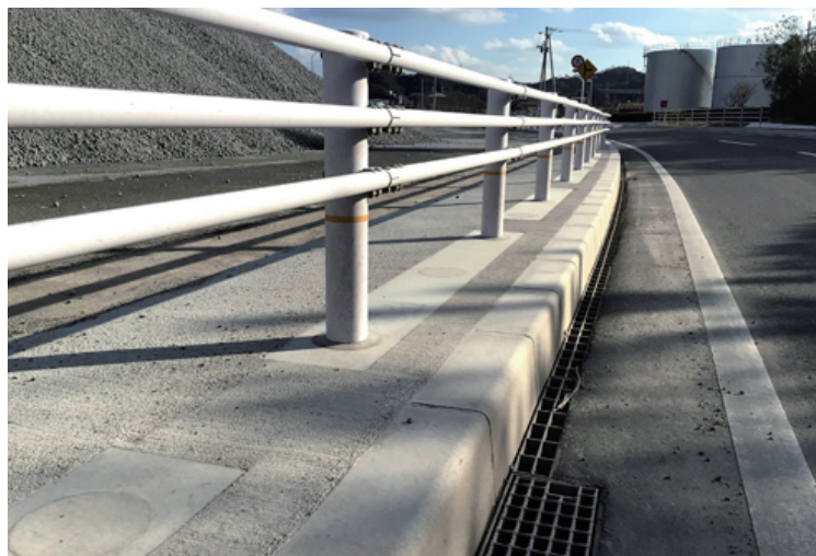
島根県 安来港臨港道路交差点改良工事
