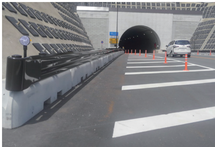
岐阜県 国道41号宮峠トンネル
