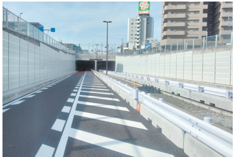
東京都 街路築造工事(3四-放35早宮)
