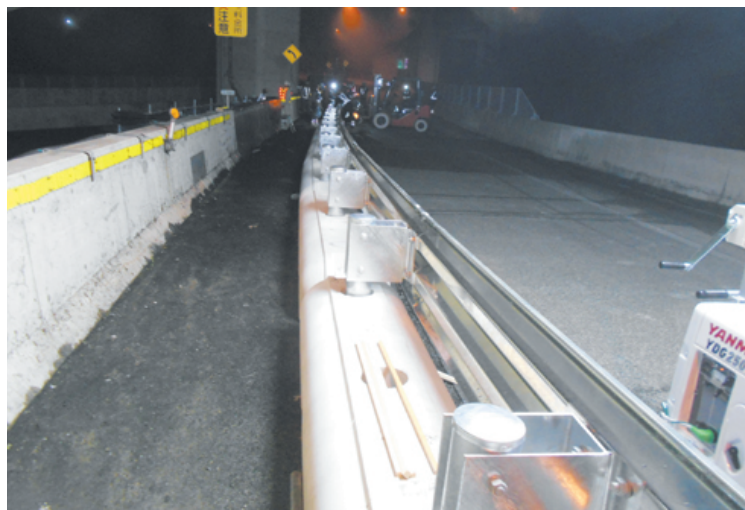
岐阜県 NEXCO中日本 飛騨清見JCT Dランプ 橋壁高欄緊急補修工事 (SC種)
