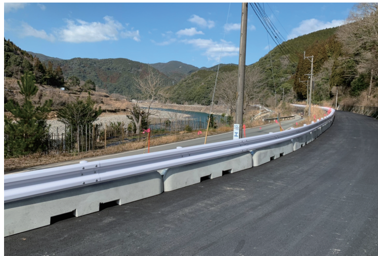
熊本県 国道219号球磨地区災害復旧他 R2熊本豪雨
