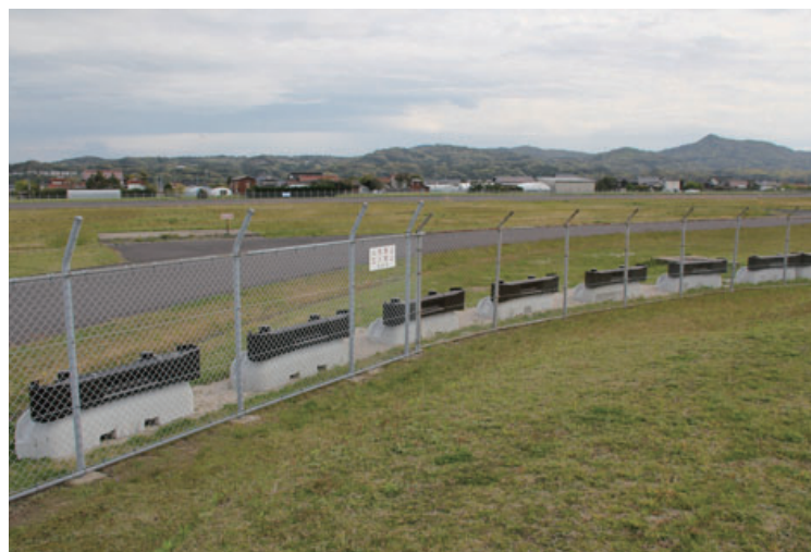
島根県 出雲空港車両進入防止施設設置工事 防犯対策
