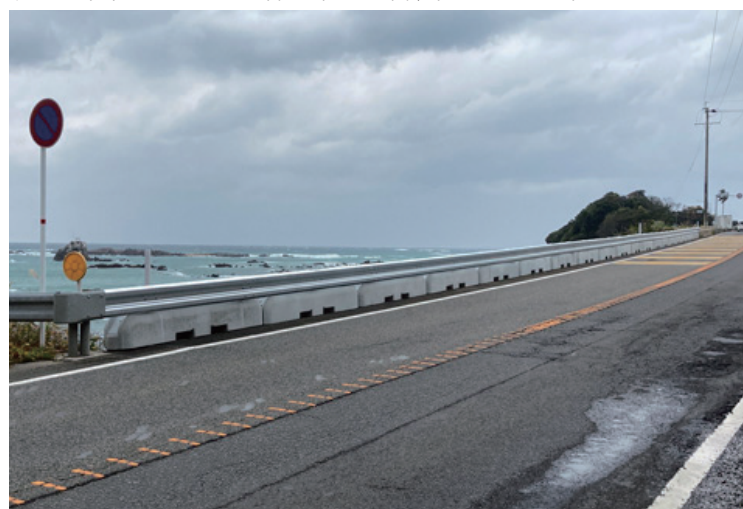
鹿児島県 国道3号線既設Gr腐食部取替工事
