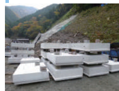
壁厚は 35 cm。壁面材の鉄筋被り 90 mm。塩害対策が必要な地域への適用も可能。
