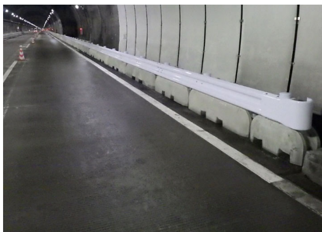
【NEXCO西日本 高知自動車道】
