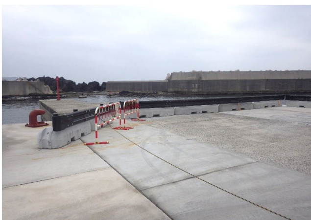
【隠岐支庁県土整備局 来居港】
