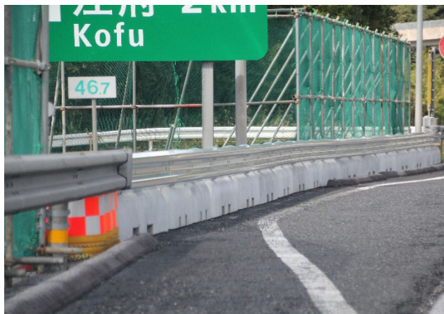
【NEXCO西日本 米子自動車道】
