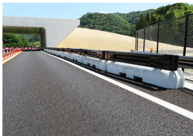
【松江国道事務所 朝山大田道路】
