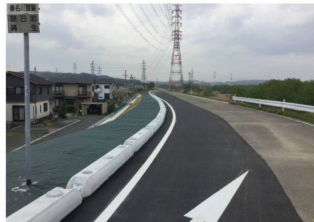
【四日市建設事務所 桑名川越線】
