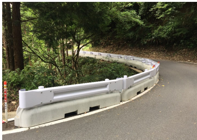
【県央県土整備事務所 維持管理業務】
