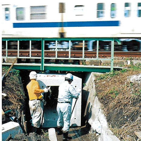
施工場所：茨城県 内 径：BOX-1000×1000
