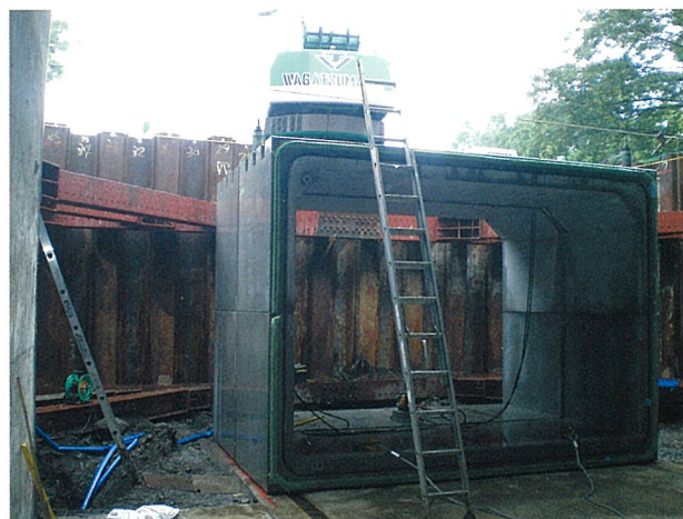
施工場所：東京都 内 径：BOX-4200×3750
