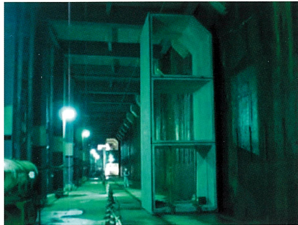
施工場所：神奈川県 内 径：3層BOX
