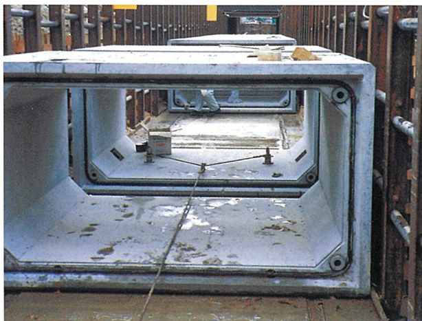
施工場所：兵庫県 内 径：BOX-2300×1300×2000
