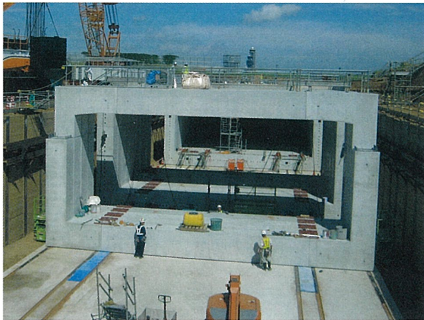
施工場所：千葉県 内 径：BOX-12500×5000
