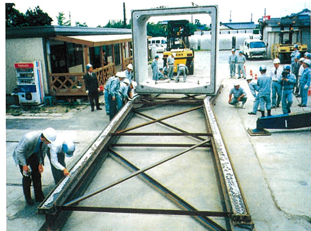
ベアリング横引き工法実験（カーブ施工）
